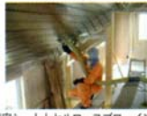
気密シートとセルロースブロウイング
